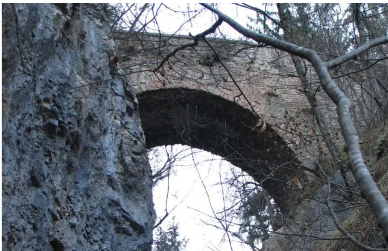
Figura 32: ponte di “Pozzena” sulla Novella, tra Revò-Romallo e Casez-Dambel.
